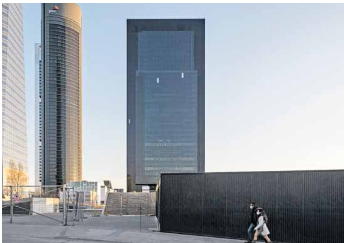
A Torre IE tem 180 metros de altura e 64 salas de aula
